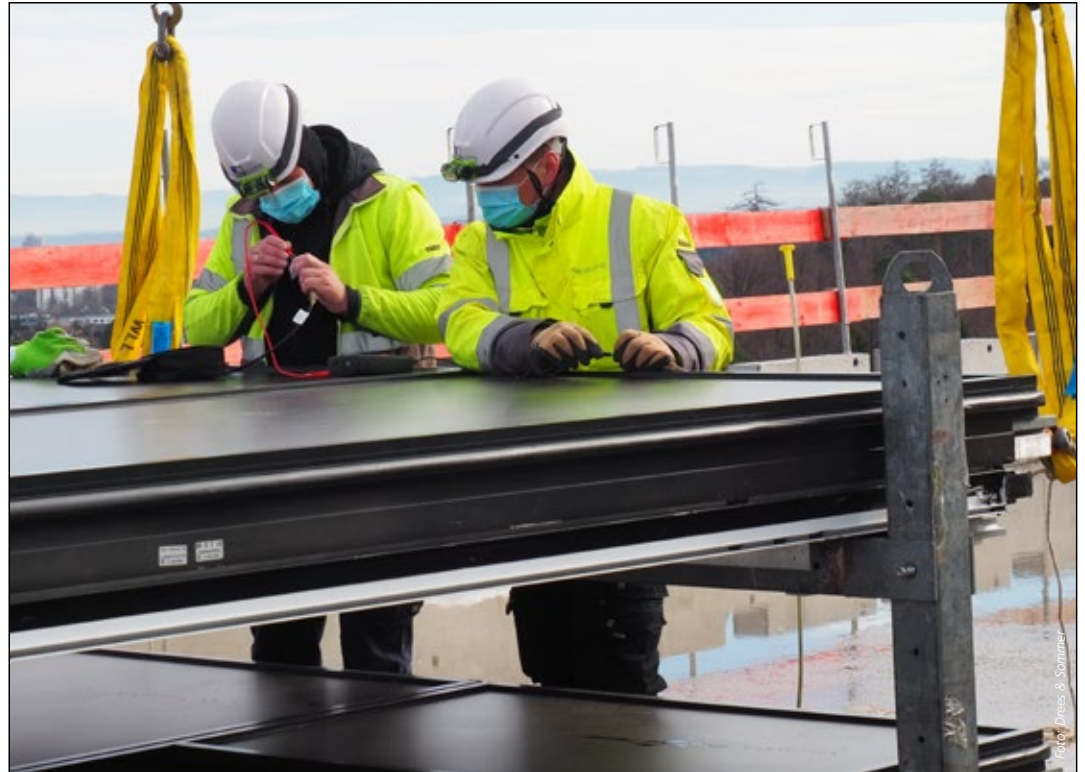
Erstmals im Neubau von Drees & Sommer eingesetzt
